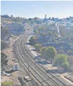
La vía del Cercanías en Torremuelle.
