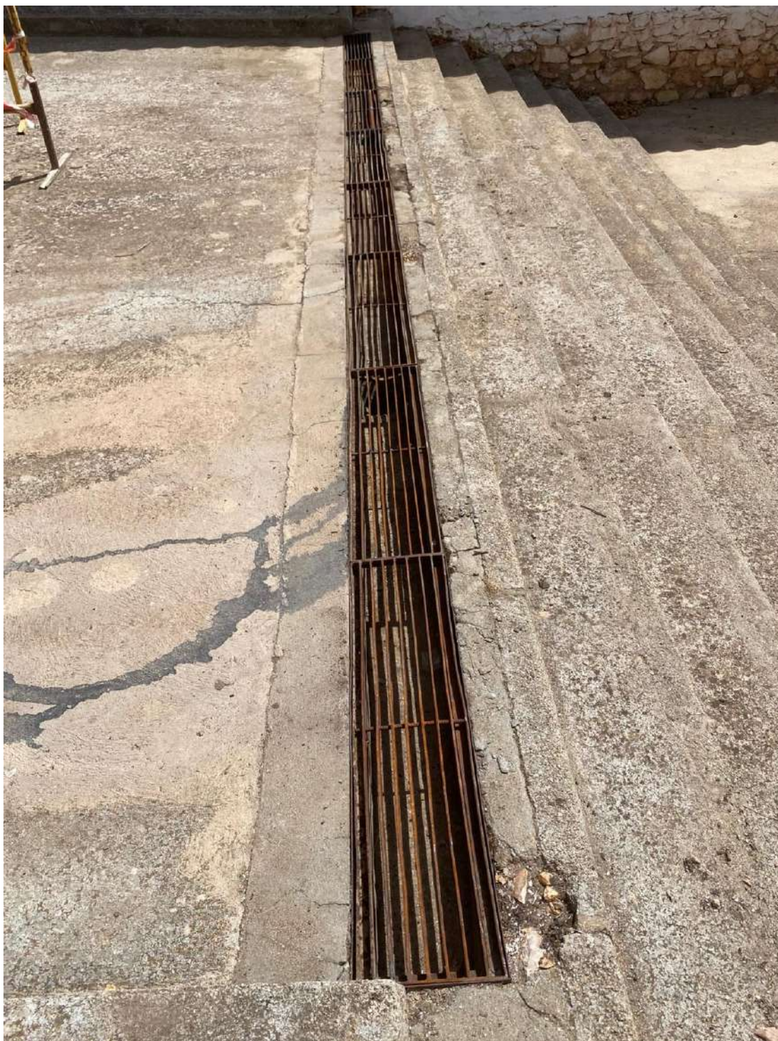
Uno de los imbornales ya totalmente limpio / G. J.
